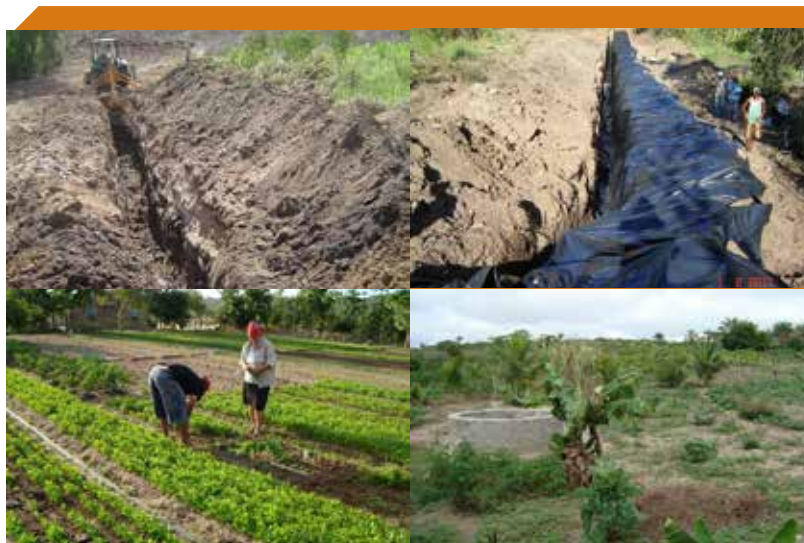
Figura 2: Barragem subterrânea em construção e produção
