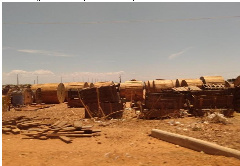
Figura 1 – Obra parada do Parque Eólico de Casa Nova I
