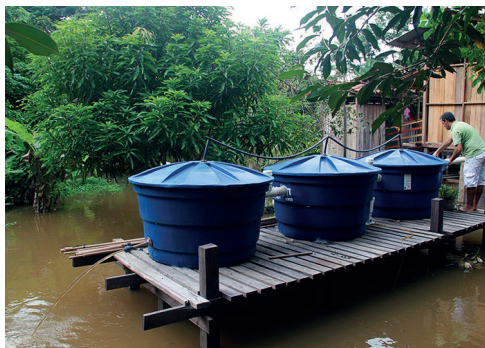
Figura 15. Fossa séptica modelo Embrapa em ilhas no Amapá.
