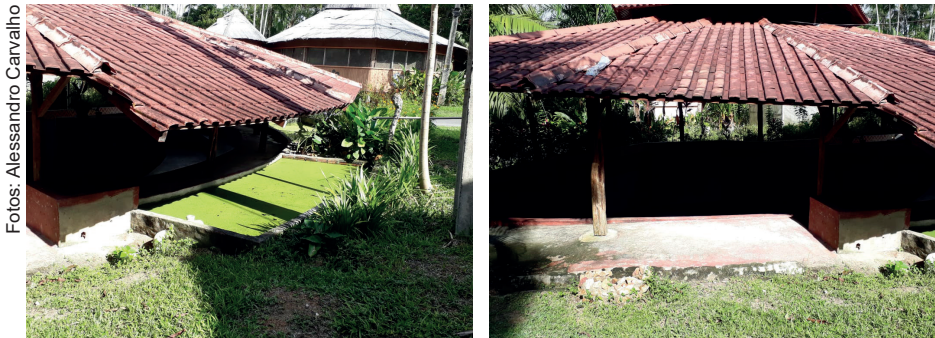
Figura 10. Tanques de peixe para a entrada de luz no auditório com telhado de PET.
