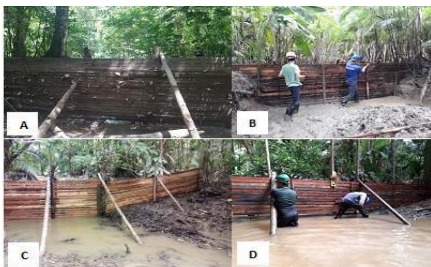
Figura 3. Primeira barreira física de madeira no igarapé da fortaleza (A); segunda barreira física de madeira no Igarapé da Fortaleza (B); primeira barreira física de madeira no Igarapé Paxicu (C); segunda barreira física de madeira no Igarapé Paxicu (D). Todas as barreiras foram instaladas pela equipe da Embrapa e extrator para a coleta de sementes de andiroba e de pracaxi na APA da Fazendinha, Macapá, AP.
