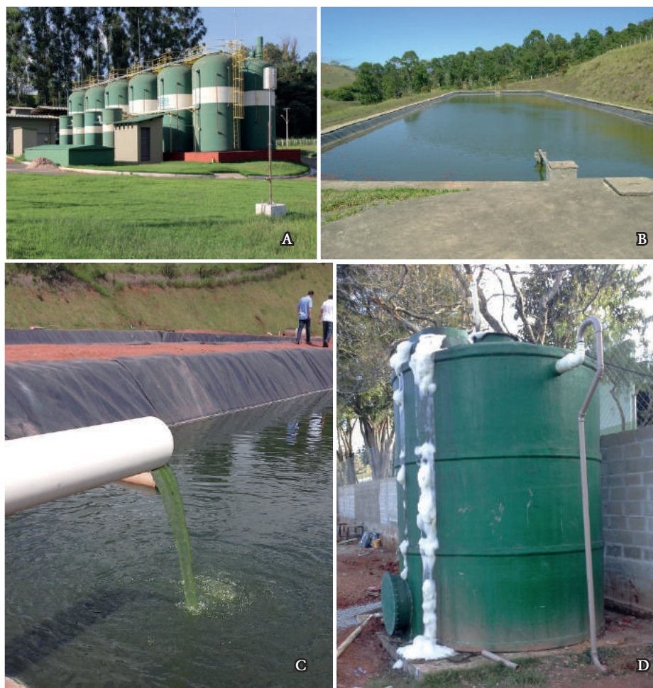
Figura 7. Exemplos de unidades secundárias de tratamento: (a) reatores UASB seguidos de biofiltros aerados submersos para tratamento de esgoto sanitário, (b) e (c) lagoas de estabilização utilizadas para tratamento de dejetos suínos e efluentes de laticínios, e (d) biofiltro aerado submerso para tratamento de dejetos caninos.
