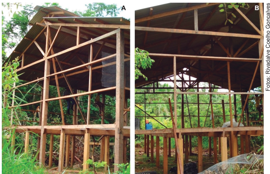
Figura 19. Vista do armazém-secador em construção pelos próprios produtores florestais – (A) vista da unidade de secagem em construção e (B) vista frontal.
