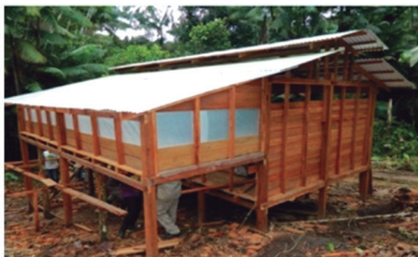
Figura 14. Paiol solar para a pré-secagem e o armazenamento de castanha-da-amazônia em áreas de produção na floresta.
