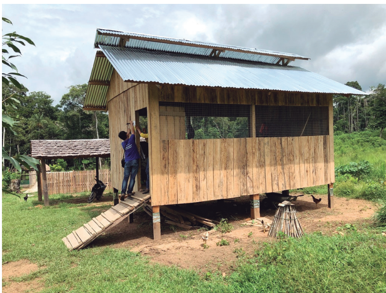
Figura 17. Vista lateral do armazém-secador com ventilação natural para produção familiar.
