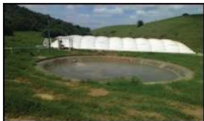
Figura 5 - (a) Biodigestor modelo Lagoa Coberta. Fonte: Elaborado pelo autor (2022). (b) esquema do biodigestor lagoa coberta / modelo canadense.
