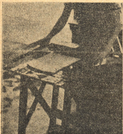
Fig. 5 — Como retirar a maior parte da água da lâmina da borracha por meio de um rolo de mão.
