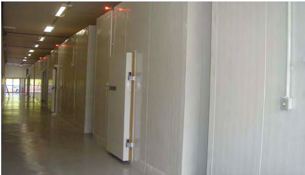
Fig. 3. Câmaras frias a -20 °C instaladas na Embrapa Recursos Genéticos e Biotecnologia em Brasília, Distrito Federal, para conservação de sementes a longo prazo.
