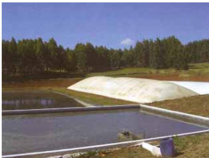
**Fig. 1.** Modelo de biodigestor usado para a geração de biogás.
