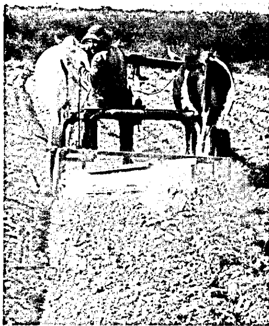
FIG. 8. Construção de um dreno usando lâmina enleiradora.
