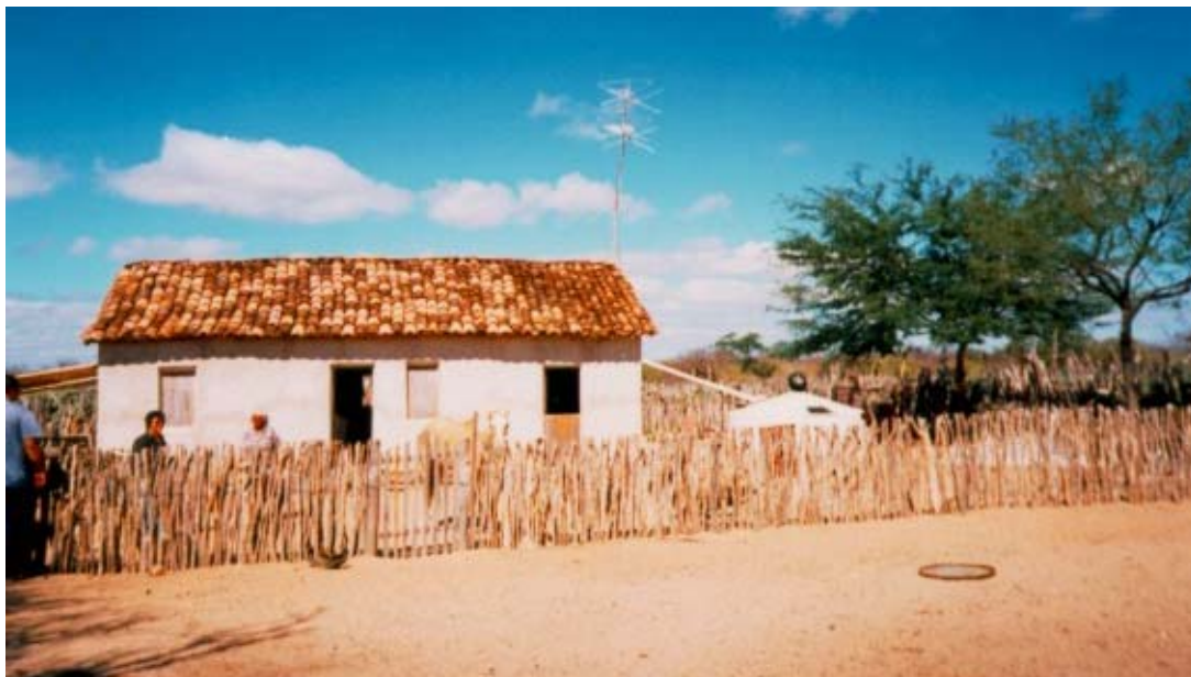
Figura 1. Residência de pequeno agricultor com uma cisterna rural.
