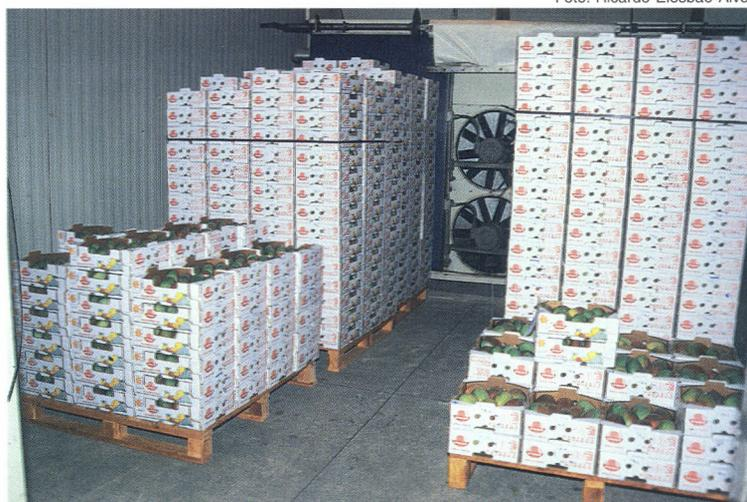
**Fig. 10.** Túnel de pré-resfriamento para manga.
