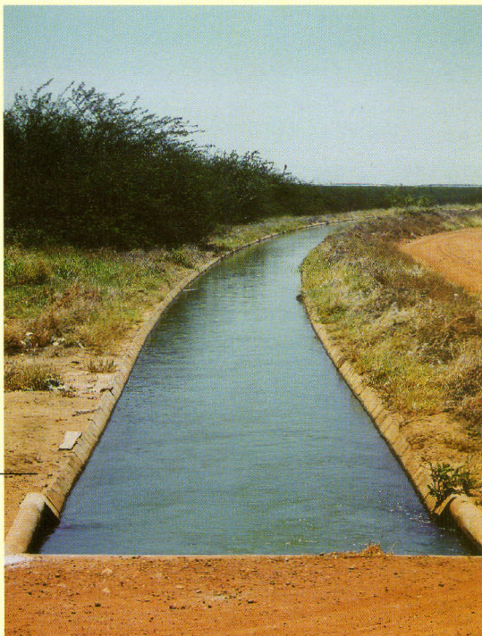
Canais para atender irrigação por sulcos com sifões e regadeiras
