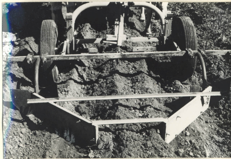
Foto 12. Enleirador acoplado aos sulcadores para confecção de camalhães
