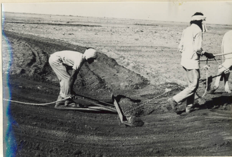
Foto 10. Versátil "scrapet" a tração animal fazendo abertura de dreno
