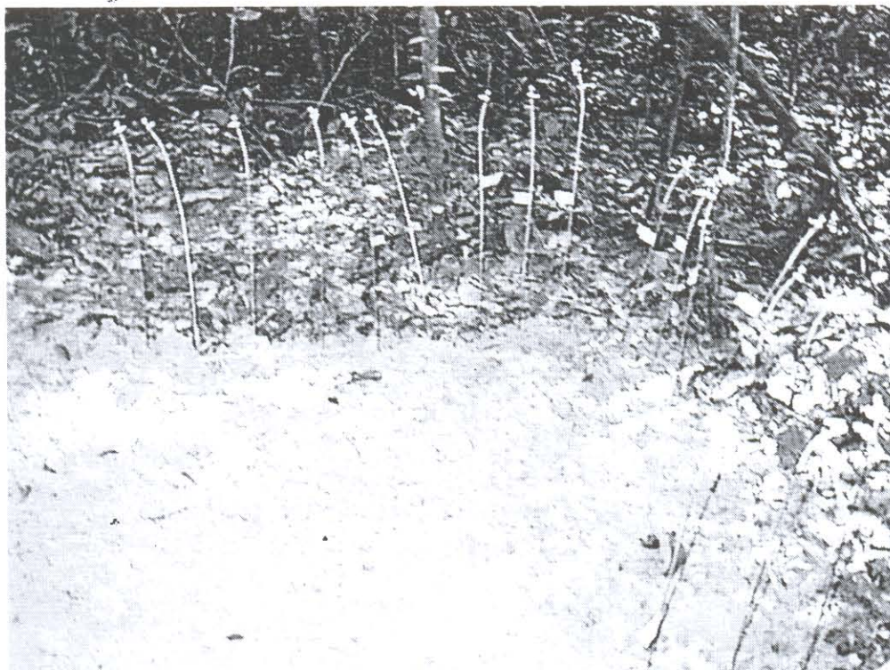
Figura 16. Tubos de aço inox para coleta de gás, em profundidade, recém instalados. Observe as torneiras de nylon na ponta dos tubos
