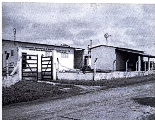
Foto 1 – Minifábrica de castanha de caju Caju – Assentamento Che Guevara
