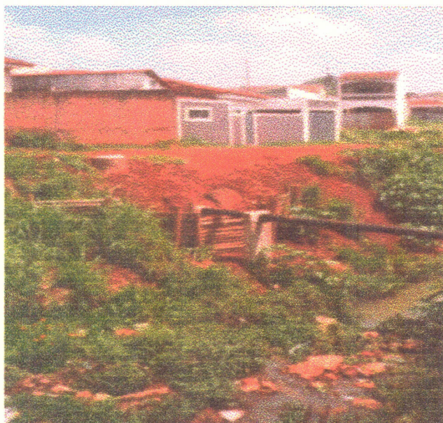
Figura 04: Construção de residências às margens do Córrego Lazarini.
