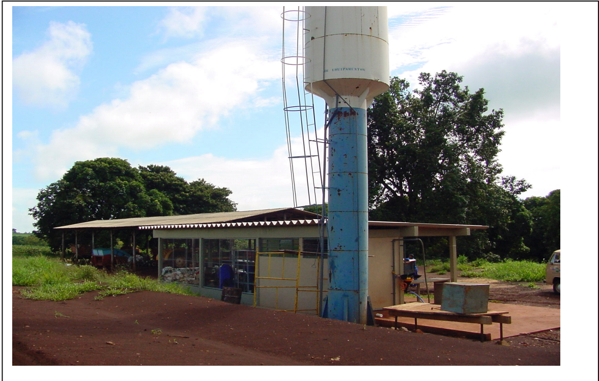
Fig. 2. Construção do Galpão de Apoio à Aplicação de Produtos fitossanitários.
