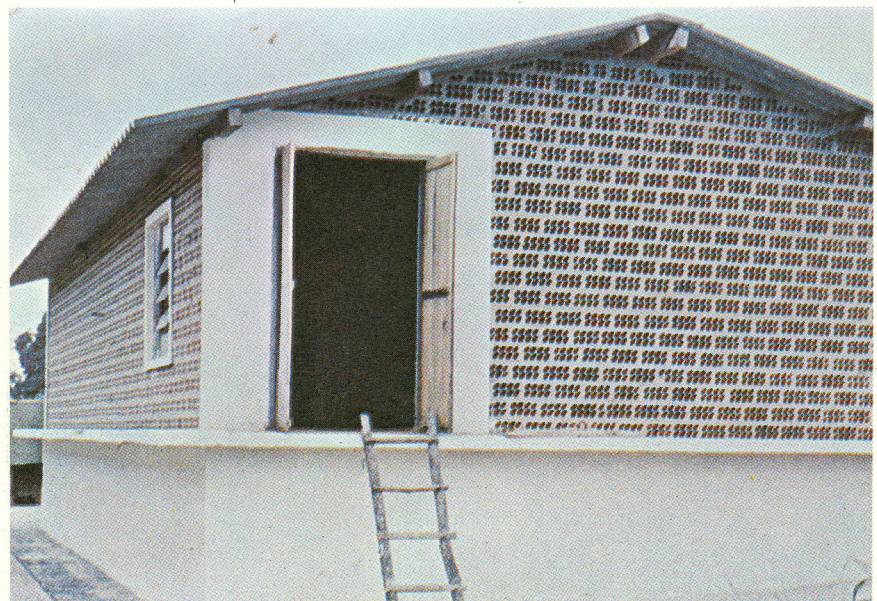
Paiol de alvenaria ventilado, construído ao nível do solo e com proteção anti-rato.
