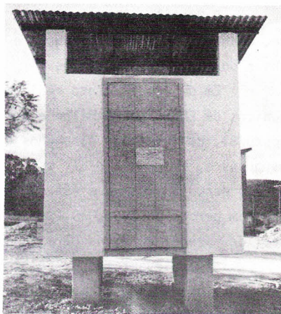
Fig. 8 - Paioi sobre pilares
