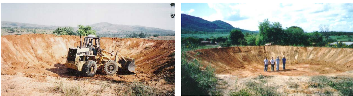
Figura 2 – Barraginha sendo construída, no Cerrado (esq.), e concluída, no Semi-árido (dir.)
