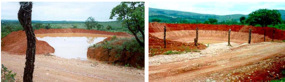
Figura 3 – Barraginha no Cerrado, logo após chuva intensa (esq.) e após 10 a 15 de infiltração no solo (dir.)
