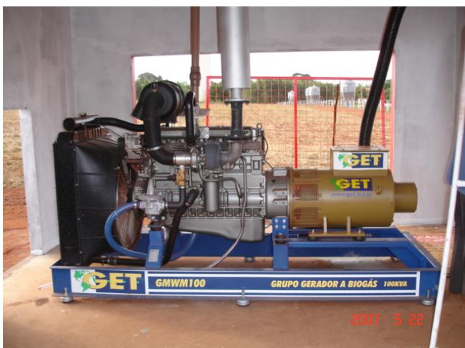
Figura 3 – Gerador de 100 Kwa, movido 100% a biogas.
