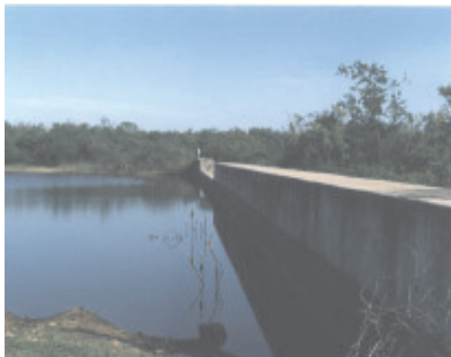
Figura 1 – Barragem de alvenaria com sérios problemas de vazamento.
