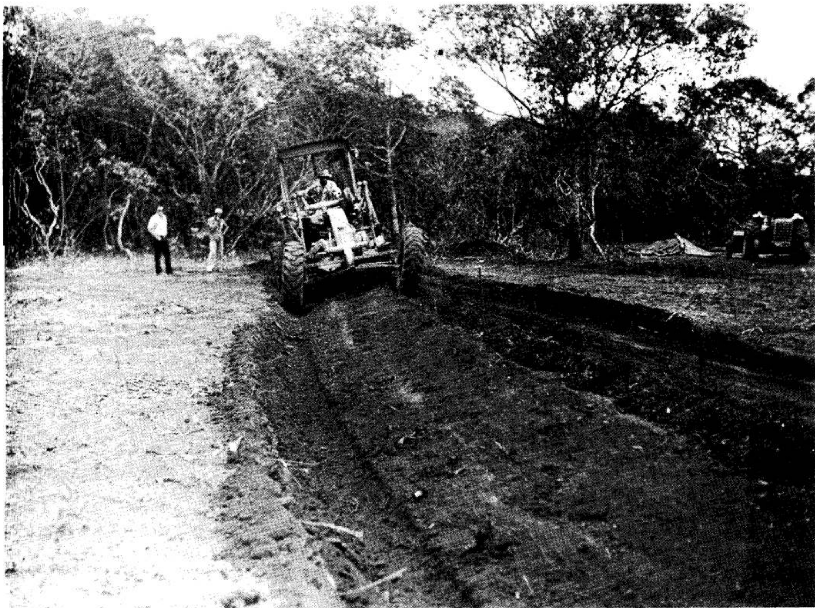
Construção de terraços de base média, utilizando-se uma patrol.
