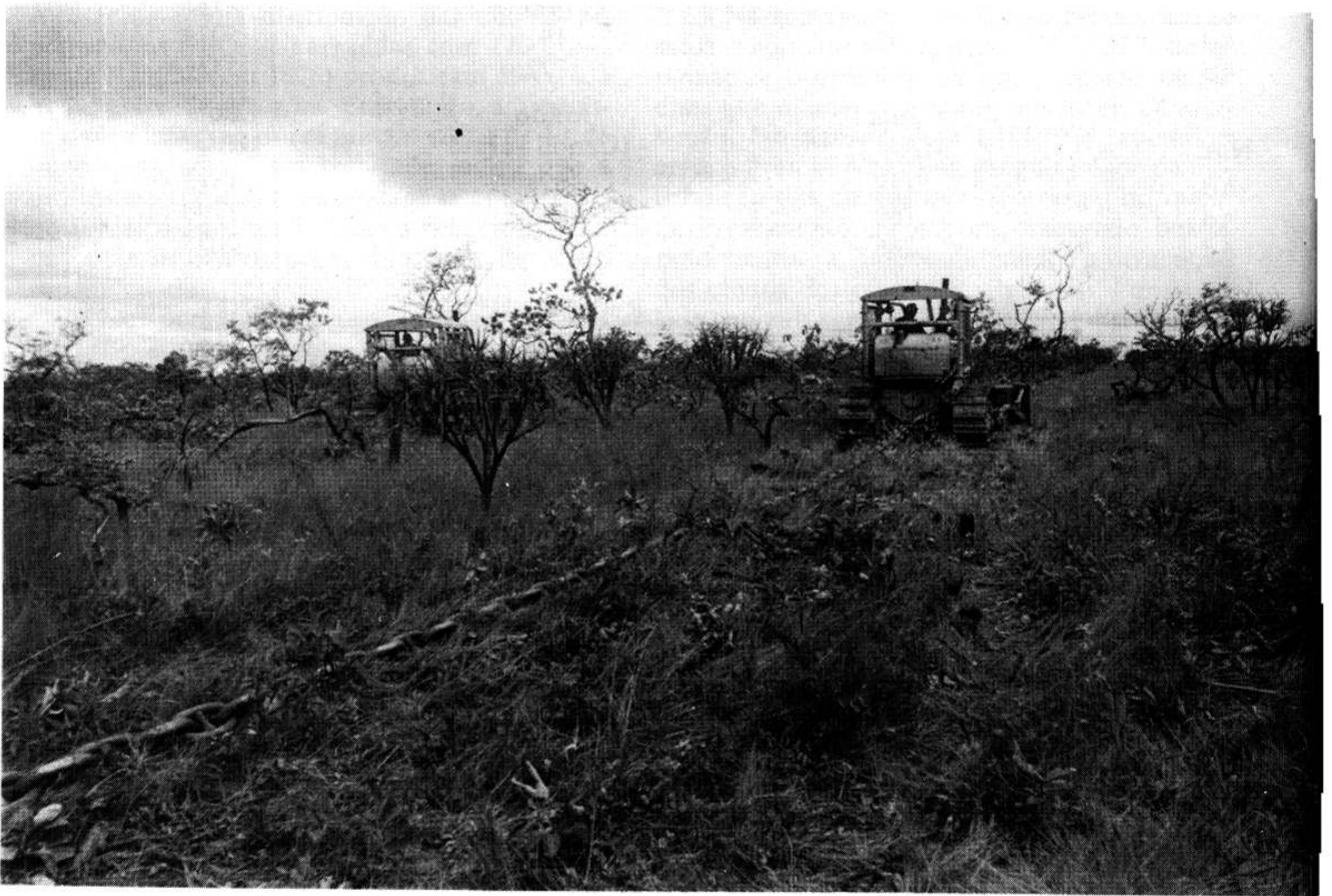
Operação de desmatamento utilizando-se o correntão.
