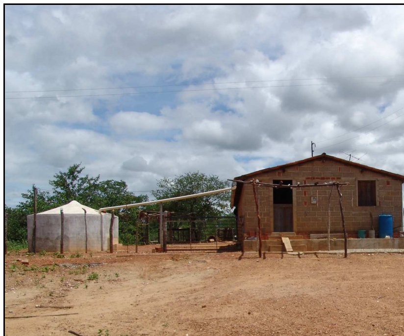
Figura 2. Aspectos da residência selecionada na Comunidade de Barreiros.
