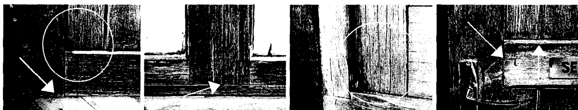
Figura 1 – Sequência de fotos de esquadrias em madeira de eucalipto - portas e janelas da Casa do Horto – UFSCar, com oito anos de utilização, revestidas com stain.
