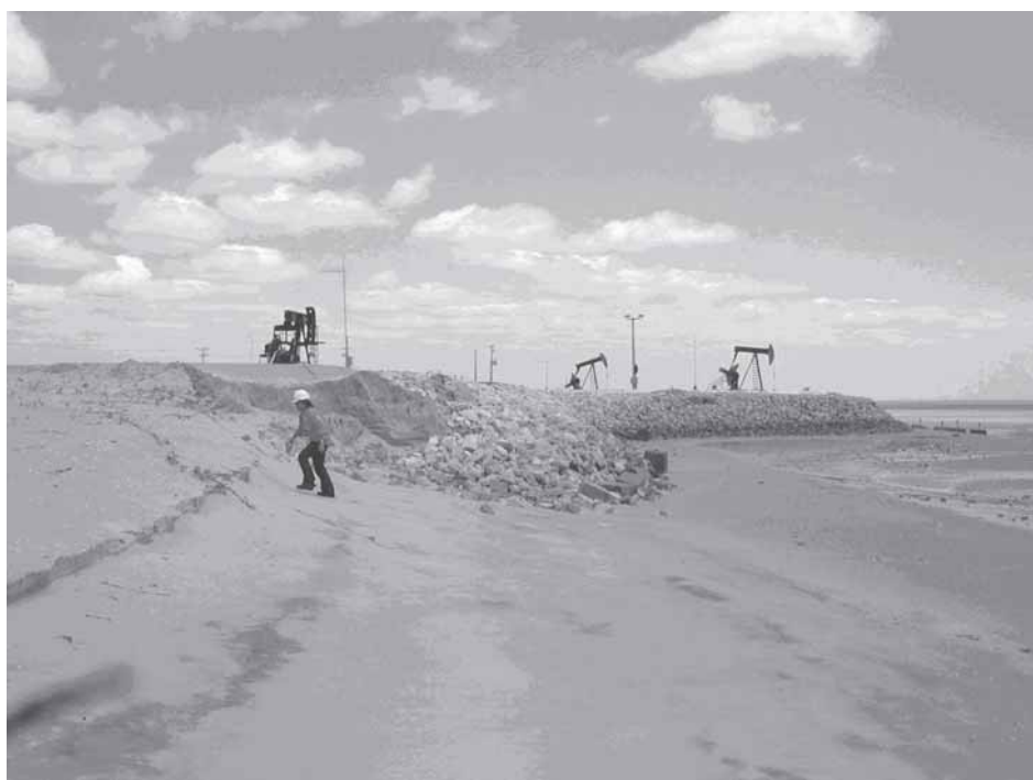
Figura 8. Ampla retrogradação do litoral colocando em risco os poços de petróleo (Ponta do Tubarão).
