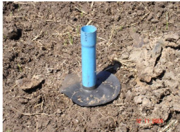
Figura 11 – Construção e instalação dos poços de observação
