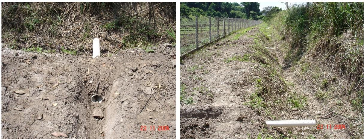
Figura 4 – Tubo de PVC instalado no final da vala da área experimental
