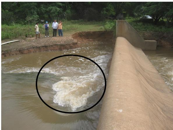
Figura 5- Açude com vazamento
