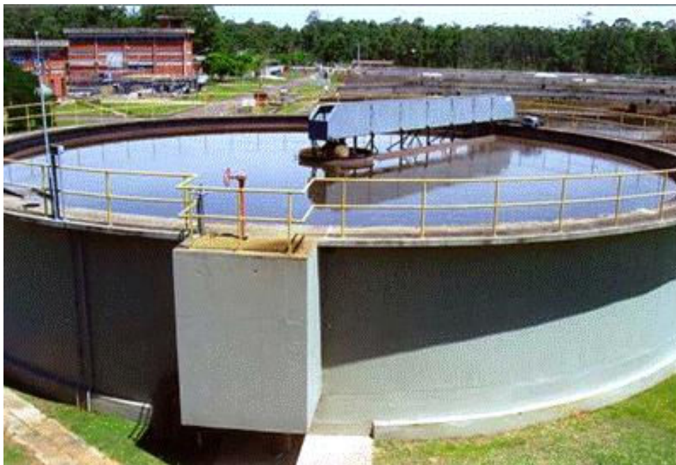
Figura 30. Estação de tratamento de efluentes. Fonte: SIAMFESP, 2009.
