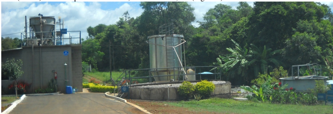
Figura 2: Estação de Tratamento de Dejetos Suínos (ETDS) da Embrapa Suínos e Aves - Concórdia/SC.
