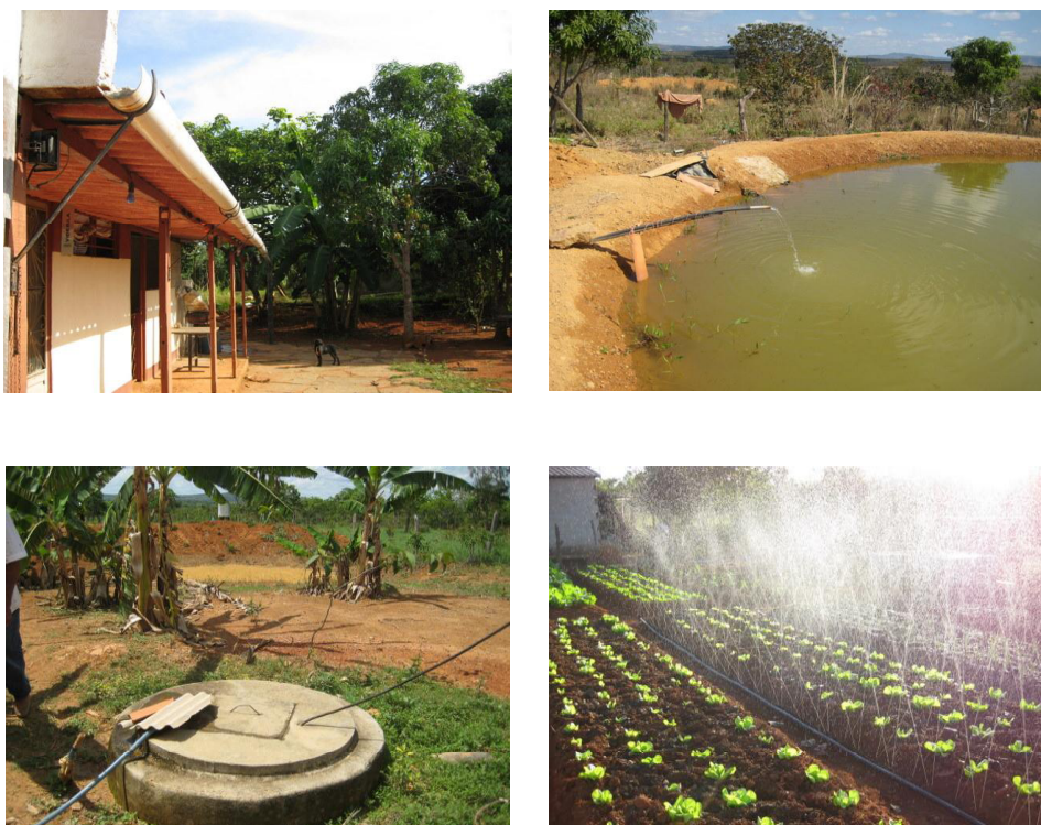
Figura 4 - Abastecimento e uso de água de chuva captada por telhado e barraginhas e armazenada no lago.
