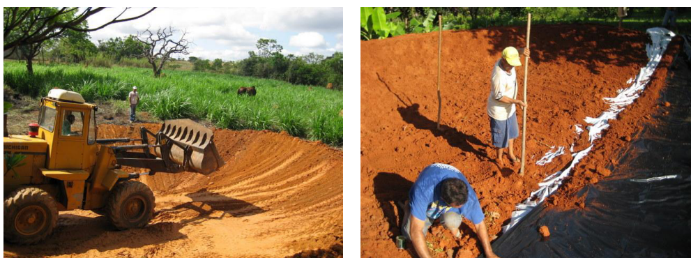
Figura 2 – Construção do lago de múltiplo uso.
