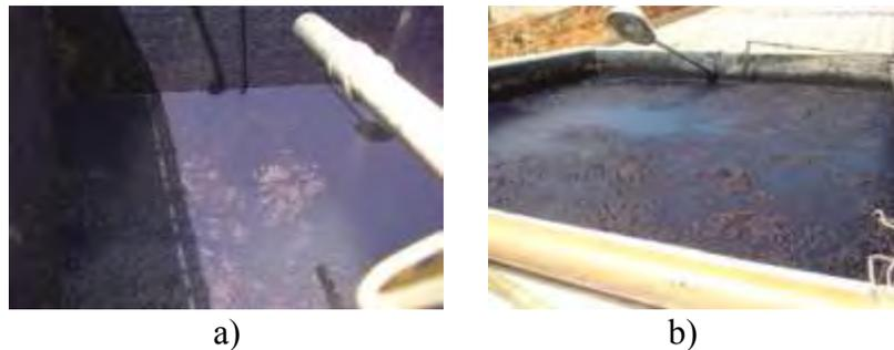
Figura 2 - Vista do tratamento de efluente típico, instalados nas lavanderias estudadas. a) Pré-tratamento (gradeamento e desaneração) e b) tratamento primário (floculação e sedimentação). (Fonte: autor.)
