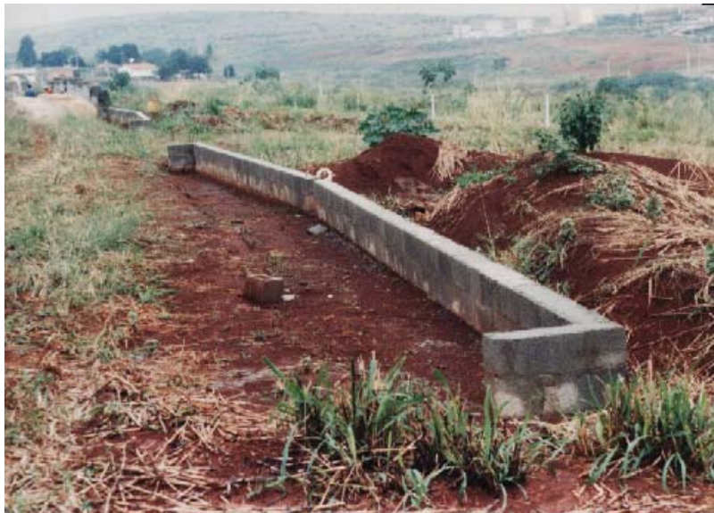
Figura 4. Vista do coletor de água e sedimento durante a sua construção.
