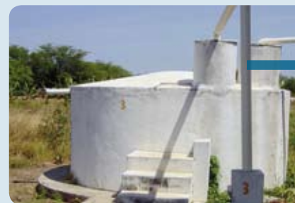
Dispositivo para desvios das 1 as. águas de chuva
