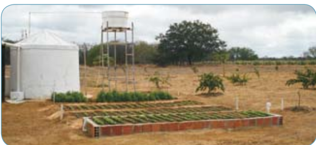
Fig. 3.2. Água de chuva armazenada em cisterna para irrigação de hortas e pomares domésticos. (Foto: Nilton de B. Cavalcanti, 2007).
