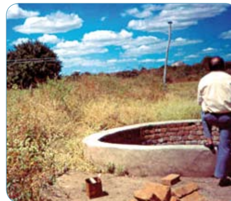
Fig. 3.4. Poço amazonas em uma barragem subterrânea. (Foto: Carlos A. da Silva, 1998)
